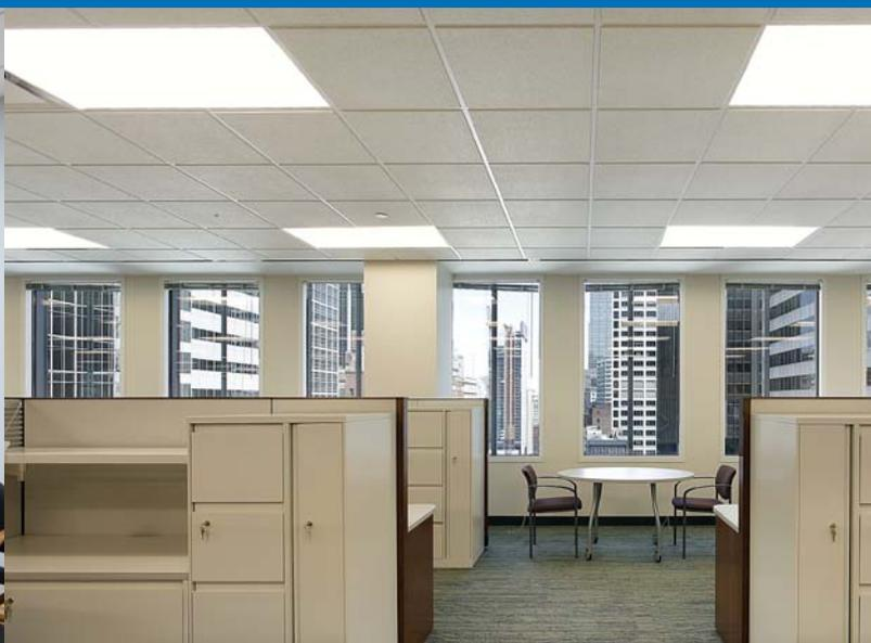
Потолочные светодиодные светильники **ULP-Q105 6060** встраиваются в подвесные потолки «АРМСТРОНГ», одинаково хорошо подходят для подвешного и накладного монтажа на ровную поверхность потолка.
